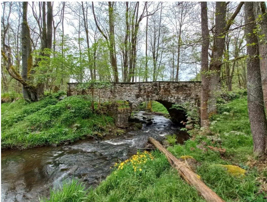
- silniční most (N2)
